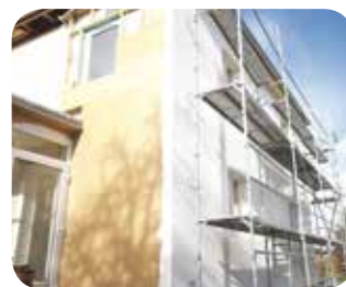
Epfig - Rénovation d'une maison en basse consommation © Nuage Nuage
