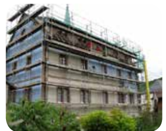
Breitenbach – Rénovation de l'école © Mairie de Breitenbach
