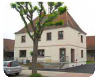
Rhinau – La Mairie rénovée en basse consommation © Energivie
